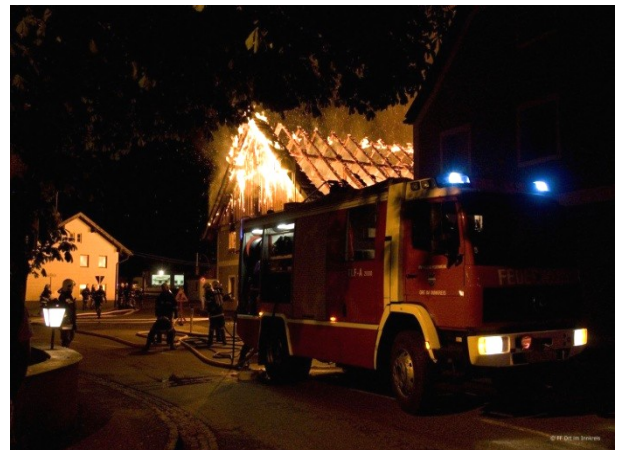
Wohnhausbrand in Ort im Innkreis
