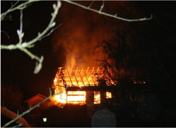
Wohnhausbrand in Reichersberg
