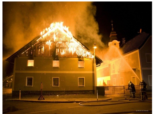
Wohnhausbrand in Ort im Innkreis
