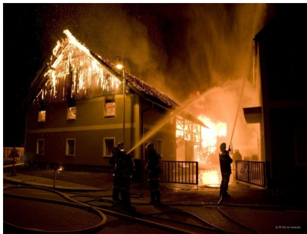
Wohnhausbrand in Ort im Innkreis
