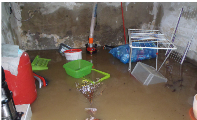
Überflutung in Weilbach
