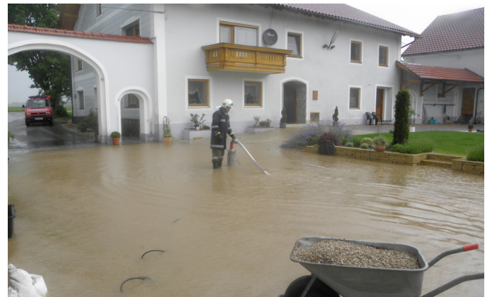
Überflutung in Katzenberg
