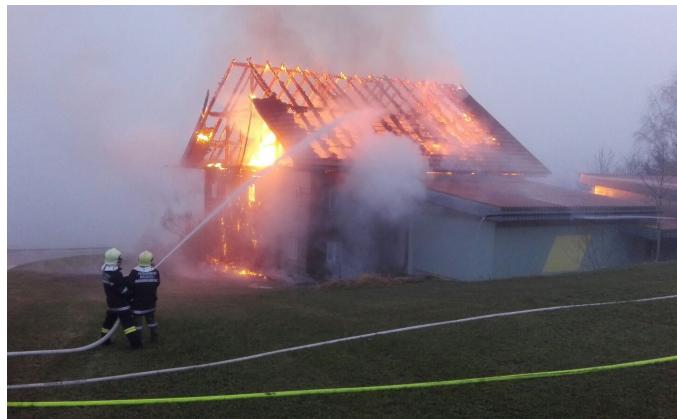
Brand Wohnhaus in Kobernaussen
