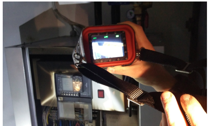
Brand Wohnhaus in Gurten
