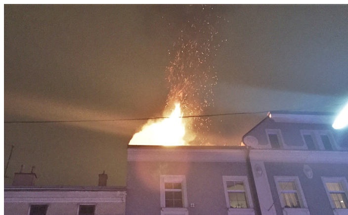
Dachstuhlbrand in Ried i. I.
